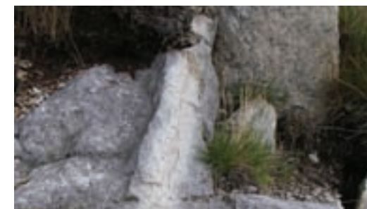
Figur 4: Sprekk med 2-3 cm hvit omdannelse på hver side av sprekken.
